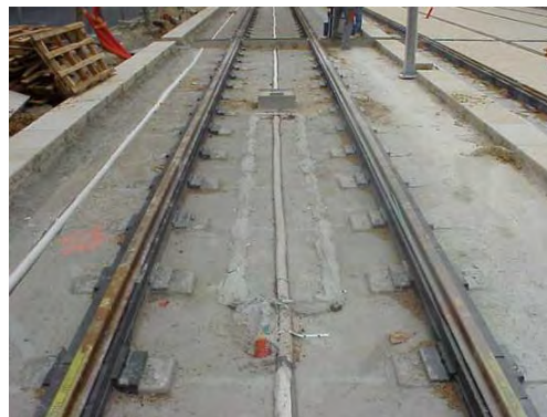
Figure 15 : Photo d'une boucle avant réalisation du revêtement de plateforme
