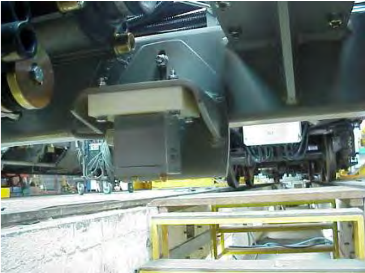
Figure 22 : Photo d'une antenne installée sous la rame
